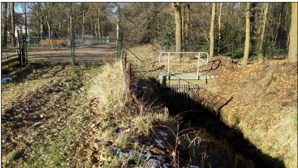
25: Op het terrein van Providentia-Kloostervelden verdwijnt de Peelven enkele honderden meters onder de grond. Foto GN
